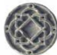
Clau d'una volta de creueria de la Seu Vella de Lleida (segle XIII). (Enciclopèdia Catalana - G. Serra)
